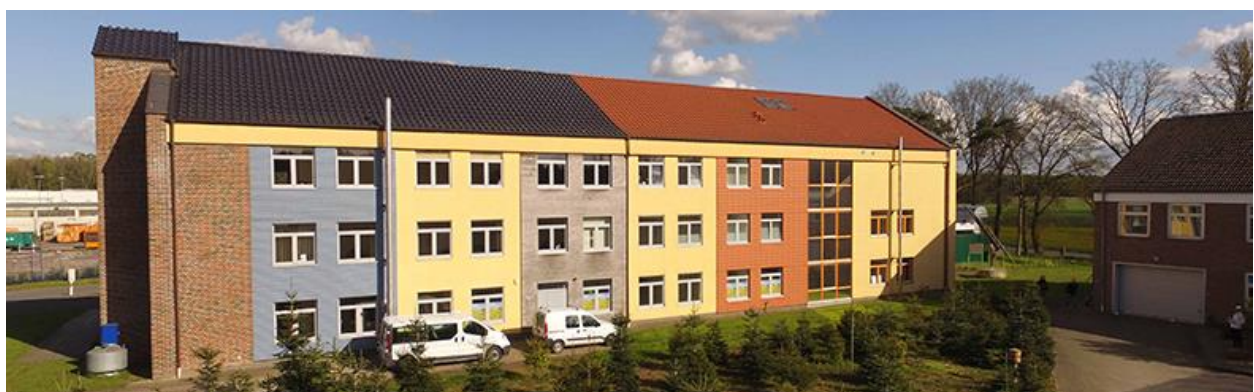
Unterschiedliche Dämmstoffe aus nachwachsenden Rohstoffen an der Fassade des Klima Centers in Werlte
