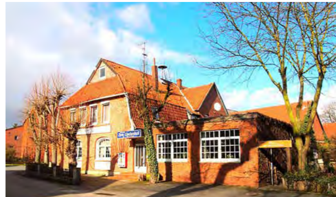
Die künftige Heimstatt des Dorfladens und Dorfgemeinschaftshauses Linsburg. Ausgangssituation vor dem Um- und Ausbau – Februar 2016
