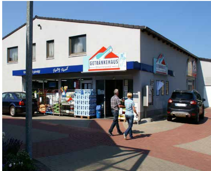
Marktpassage im Ostercappelner Kaufhaus nach der Neugestaltung der Fassade und der Pflasterung
