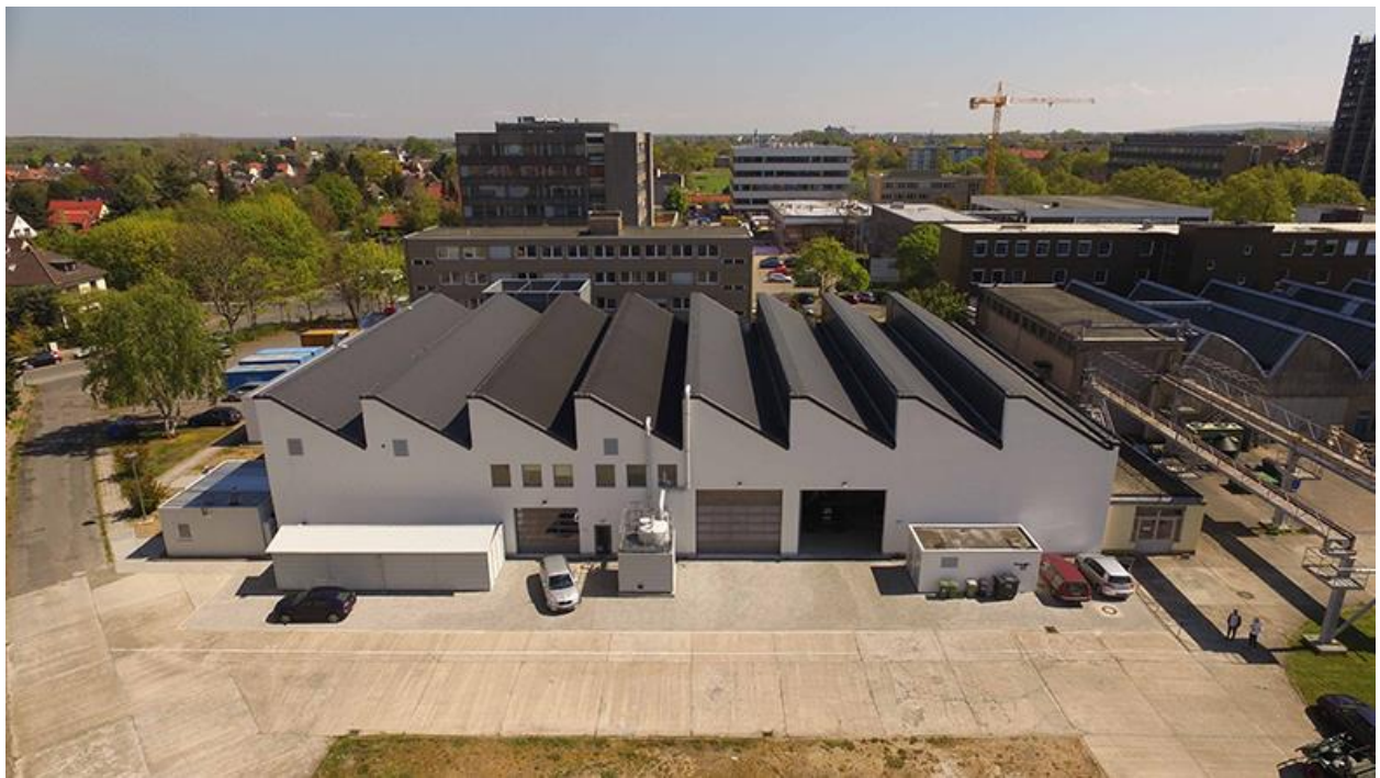
Das Gebäude der Battery LabFactory
